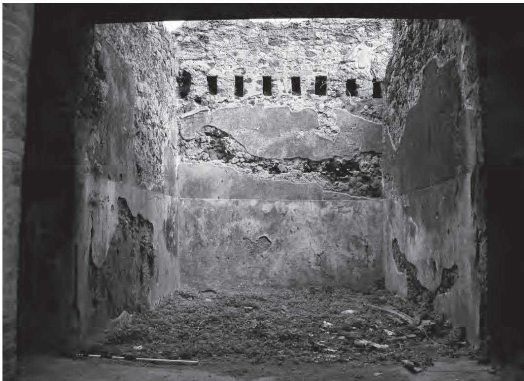
FIG. 15. Casa del Doppio Impluvio (VI.15.9), Pompeii, ala with sockets for loft in north wall.
